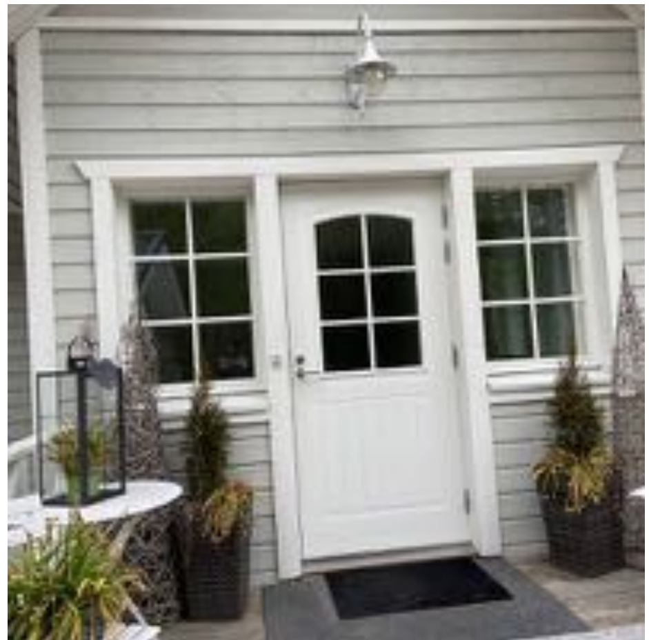
28. Yleiskuva: Rakennuksen ulko-ovien kunnossa ei havaittu puutteita.
