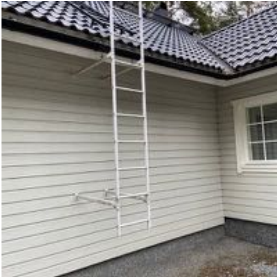
6. Yleiskuva: Seinätikkaiden asennuksessa ei havaittu puutteita.
