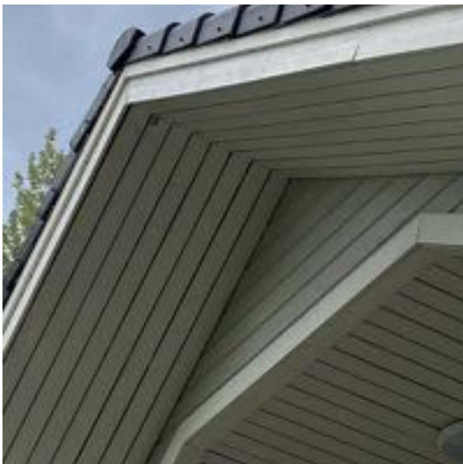
12. Yleiskuva: Räystään leveys on suositusten mukainen (leveä räystäs). Räystään tehtävänä on estää veden tunkeutuminen katto- ja seinärakenteisiin ja mahdollistaa yläpohjan tuuletus.
