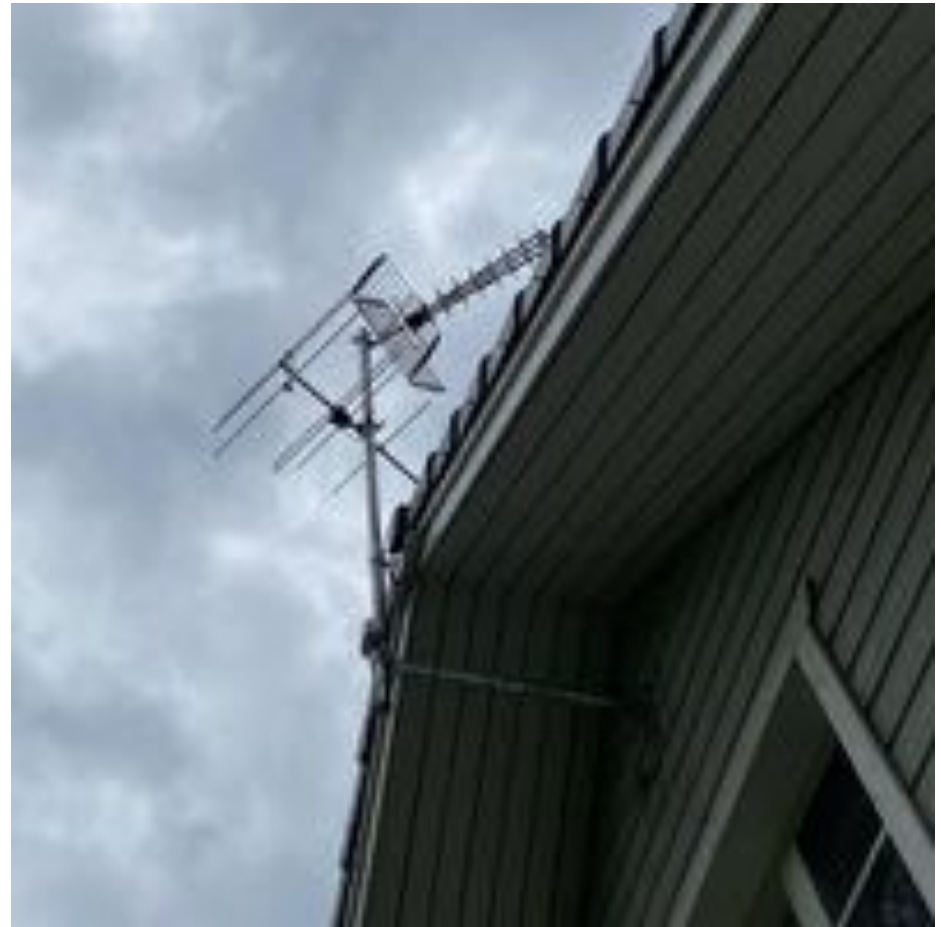
11. Yleiskuva: Antenniputki on asennettu kattorakenteen ulkopuolelle (ei kosteusvaurioriskiä).
