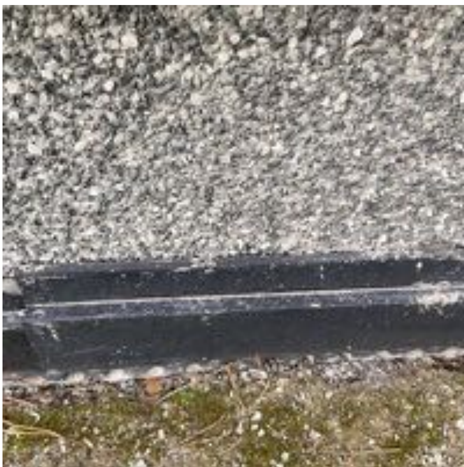
39. Yleiskuva sokkelista. Sokkelissa ja sen pinnoitteessa ei havaittu puutteita tarkastetuilta osin.
