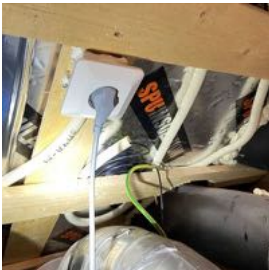
20. Yleiskuva: Yläkerran teknisestä tilasta saatiin näköyhteys yläpohjan eristemateriaalista (SPU).
