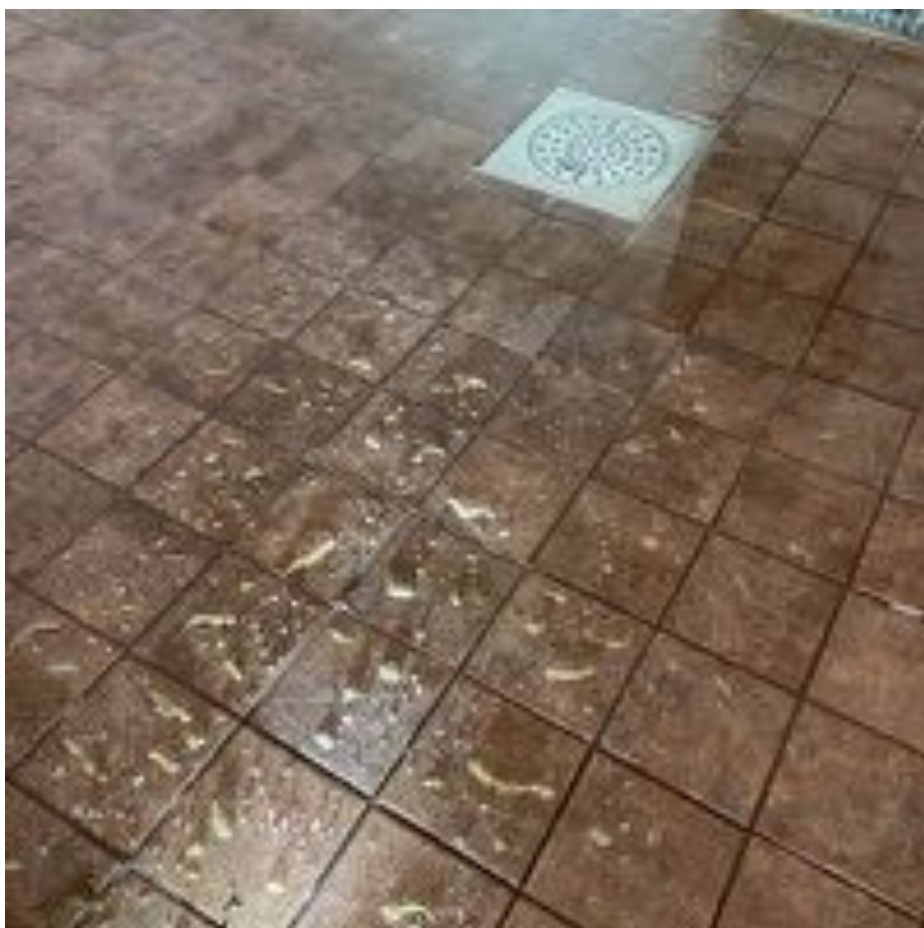
43. Yleiskuva: Lattian kaato testattiin vesikokeella (suihku päällä). Lattian kaadot kohti lattiakaivoa ovat ohjeiden mukaiset. Suositellaan lattian kuivaamista lattialastalla aina suihkun jälkeen.
