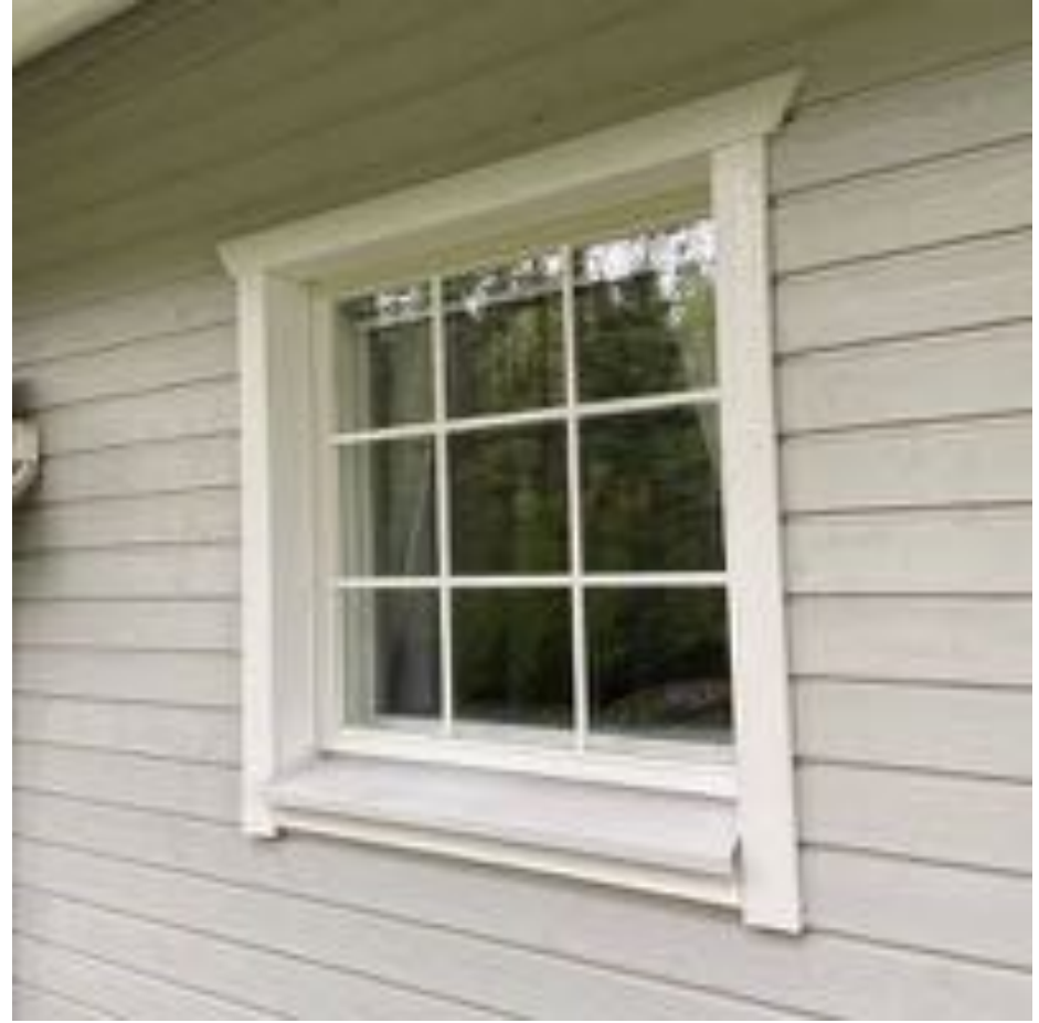
26. Yleiskuva: Rakennuksen ikkunoissa ei havaittu puutteita tai vaurioita.
