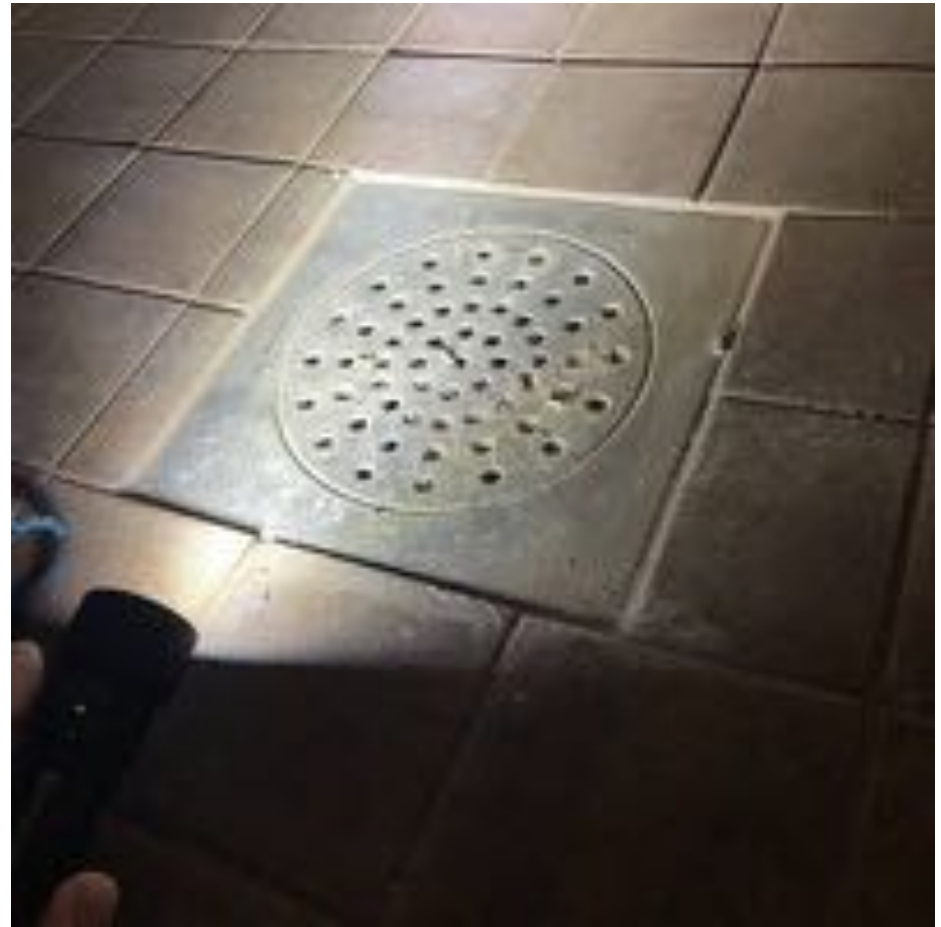
42. Yleiskuva: Saunan lattian vedenpoisto on järjestetty kuivakaivolla. Kuivakaivon asennus on nykyohjeiden mukainen (havaittu vahvikekangas kiristysrenkaan alla).
