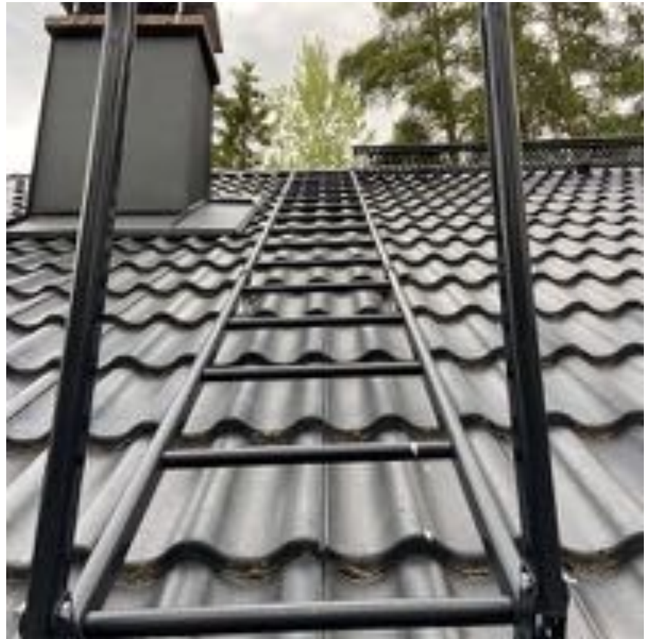
7. Yleiskuva: Katolle on asennettu lapetikkaat ja kulkusilta. Katolla sijaitseville säännöllistä käyntiä edellyttäville rakennusosille (hormeille) on järjestetty tarkoituksenmukainen, katkeamaton kulkutie.
