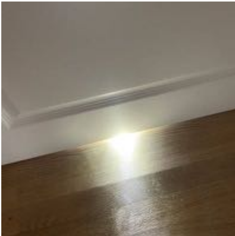
60. Yleiskuva: Rakennuksen siirtoilmareitit ovat tarkasteltavilta osin toimivia. Toimivan ilmanvaihdon kannalta on tärkeää, että ilma pääsee esteettä liikkumaan huoneiden välillä myös ovien ollessa kiinni.
