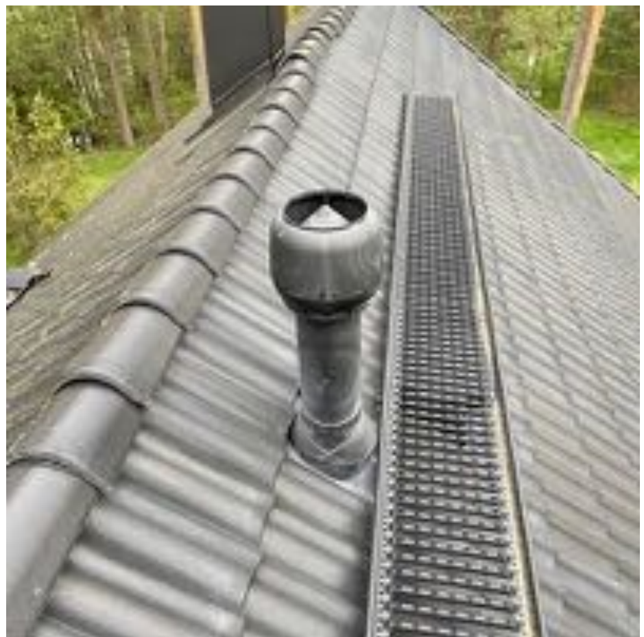
9. Yleiskuva: Katteen läpivientien kunnossa ei havaittu puutteita.
