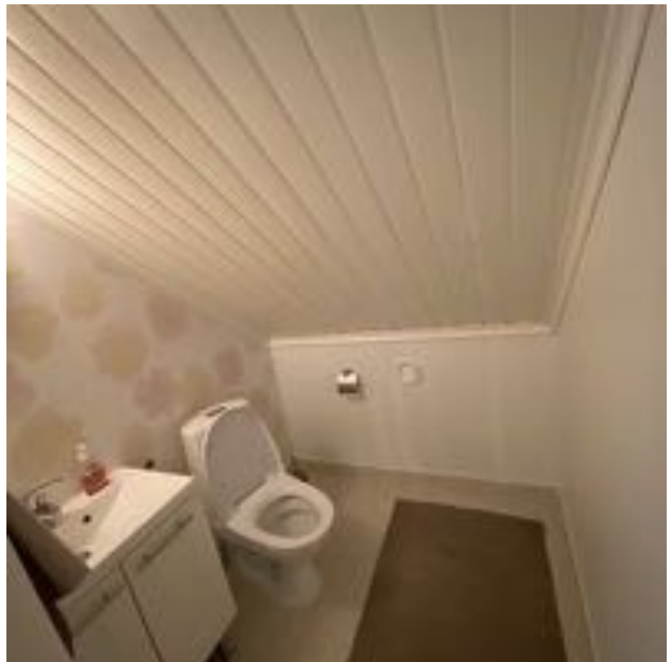
84. Yleiskuva yläkerran wc-tilasta.
