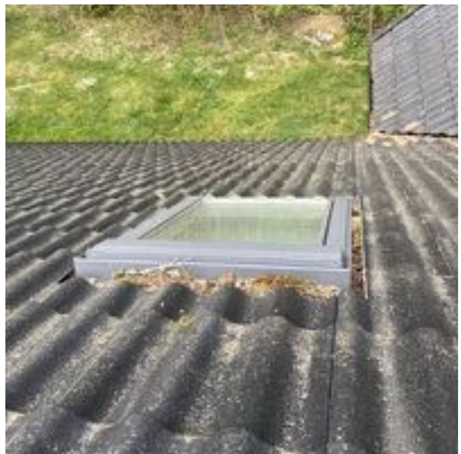
13. Yleiskuva kattoikkunasta. Kattoikkunassa ei havaittu sisältä- ja ulkoapäin havainnoidessa viitteitä kosteusrasituksesta. Kattoikkunan vesitiiviyyden varmistamiseksi kattoikkuna tulee huoltaa säännöllisesti.
