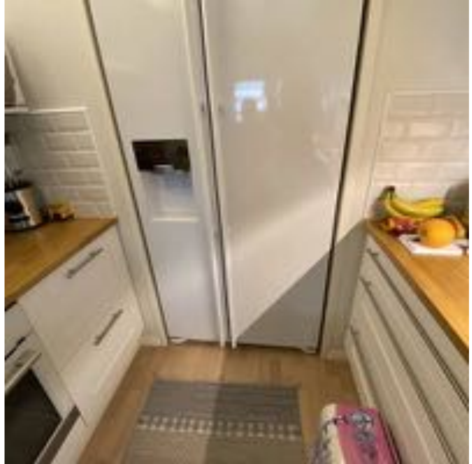
67. Kylmäkaappien alla ei ole valuma-altaita. Suositellaan asentamaan valuma-allas tai vuotohälytin kylmäkaappien alle mahdollisten vuotojen havaitsemiseksi.
