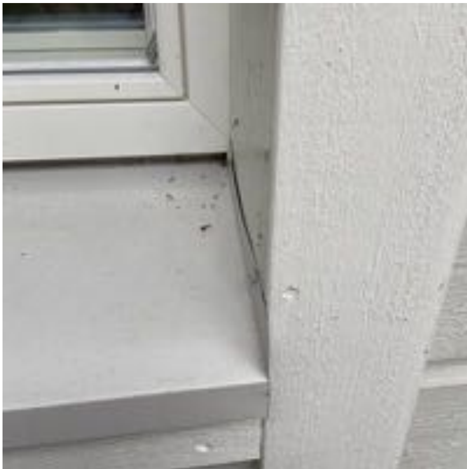
27. Yleiskuva: Ikkunoiden vesipeltien asennukset ovat tarkastetuilta osin tiiviit. Tiiviillä asennuksella estetään sade- ja valumavesien pääsy seinärakenteisiin. Suositellaan vesipeltien tiiveyden varmistamista säännöllisellä huollolla.
