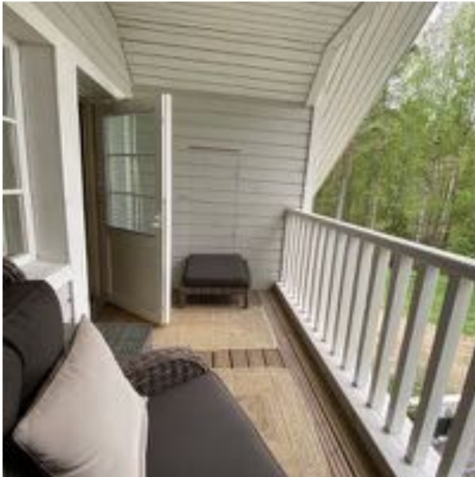
29. Yleiskuva: Parvekkeen rakenteissa ja kunnossa ei havaittu puutteita. Parvekkeen puuosien kunto tulee tarkastaa säännöllisesti ja tarvittaessa huoltaa niiden kestävyuden varmistamiseksi.
