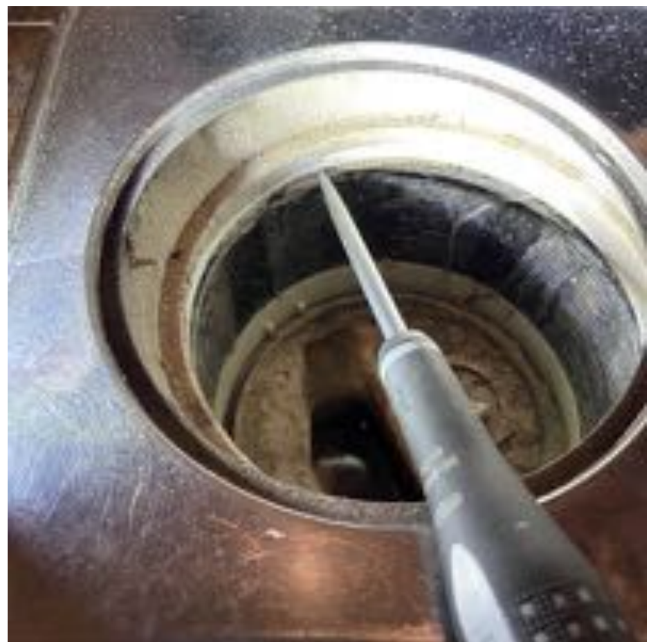
44. Yleiskuva: Lattiakaivosta havaittiin vahvikekangas kiristysrenkaan alta. Lattiakaivon asennus on nykyohjeiden mukainen.
