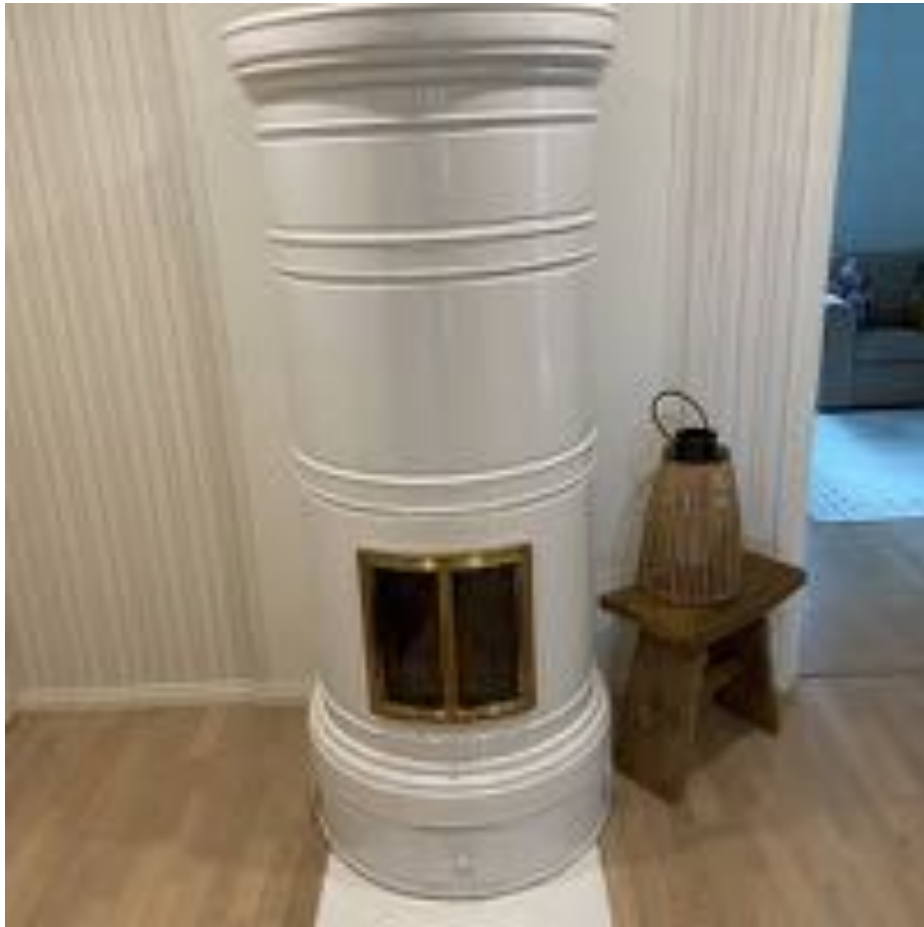
49. Yleiskuva asunnon tulisijasta (eteisaula). Tulisijassa ja sen kunnossa ei havaittu puutteita.
